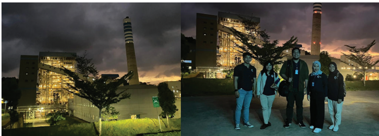
Gambar 2.30a & 2.30b Pembangkit Listrik Tenaga Uap Kalbar 1
